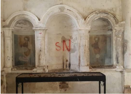
Fotoğraf 3: Vaftizci Yahya Kilisesi, Apsis Cephesi Güney Yan Duvarı (Fot: E. Avcı)
