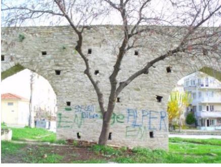
Fotoğraf 50: Kuşadası, Özer Türk Stadyumu Yanı, Neapolis Su Kemerinin Batı Cephesi Duvarı (Fot: V. Acar)
