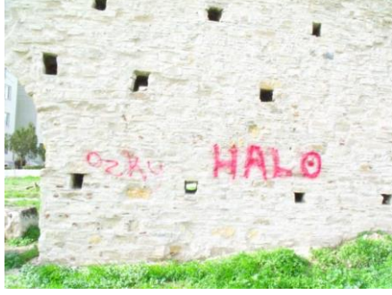
Fotoğraf 51: Kuşadası, Özer Türk Stadyumu Yanı, Neapolis Su Kemerinin Doğu Cephesi Duvarı (Fot: V. Acar)
