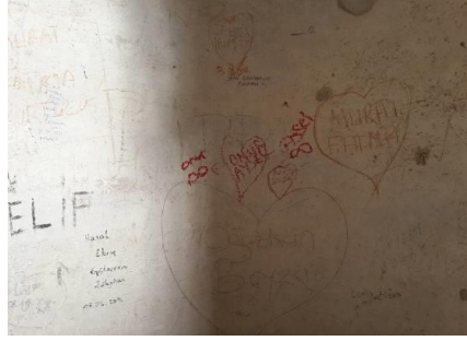
Fotoğraf 6: Vaftizci Yahya Kilisesi, Apsis Cephesi Kuzey Yan Duvarı Detay (Fot: E. Avcı)
