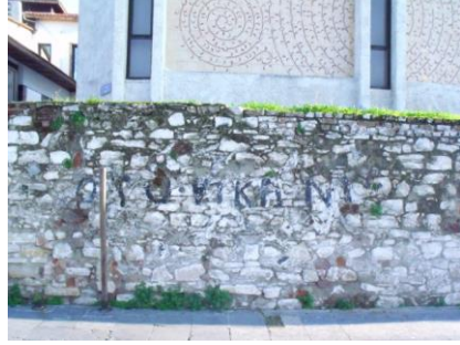
Fotoğraf 43: Kuşadası, Atatürk Bulvarı, Sur Duvarı, Kuzey Cephe (Fot: V. Acar)
