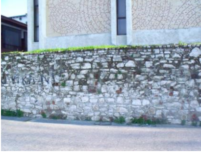
Fotoğraf 42: Kuşadası, Atatürk Bulvarı, Sur Duvarı, Kuzey Cephe (Fot: V. Acar)
