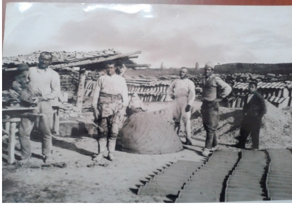
Şekil 3. Sırören Köyü Kiremit üretimi yapan ustalar
